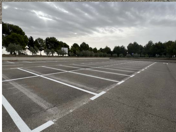
Parking edificio Guara
