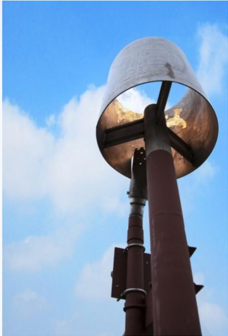
El **BIOGÁS**, mayoritariamente es metano, es conducido a un motor de cogeneración o en su defecto a una antorcha para el quemado y transformación en  $CO_2$ .
